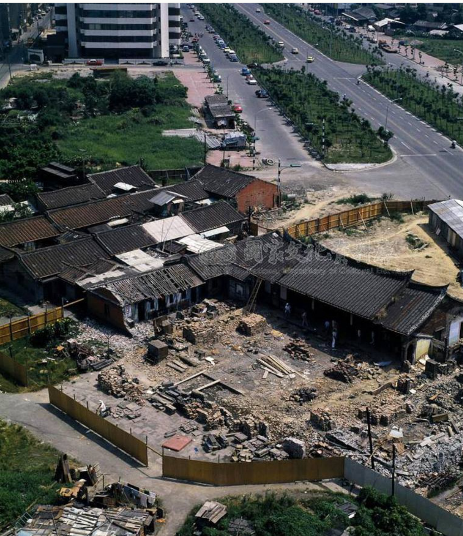
▲林安泰古厝拆遷紀錄 圖片來源：國家文化資料庫。
