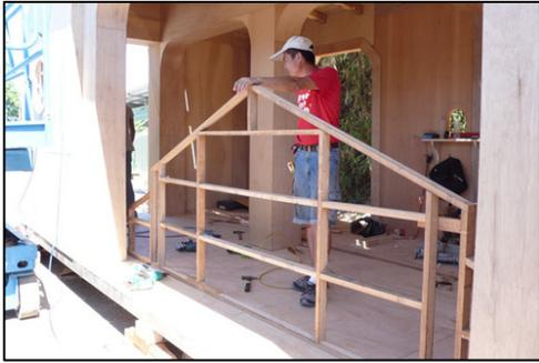
圖 6 新舞臺屋頂結構製作
