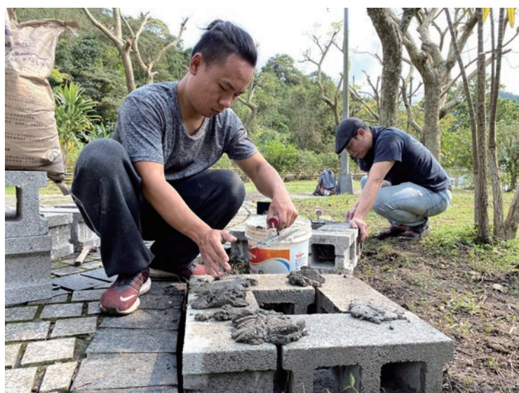
▲雨水回收桶施工中。圖源：南港茶水間。
