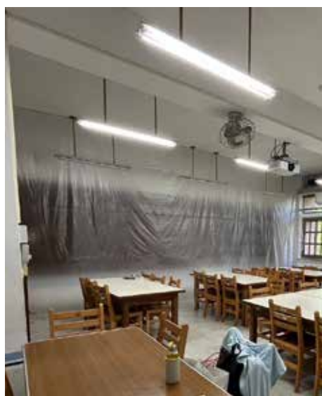
▲施工防護措施
