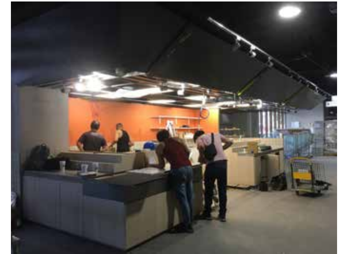
▲圖 2 攤位裝修案接近完工
