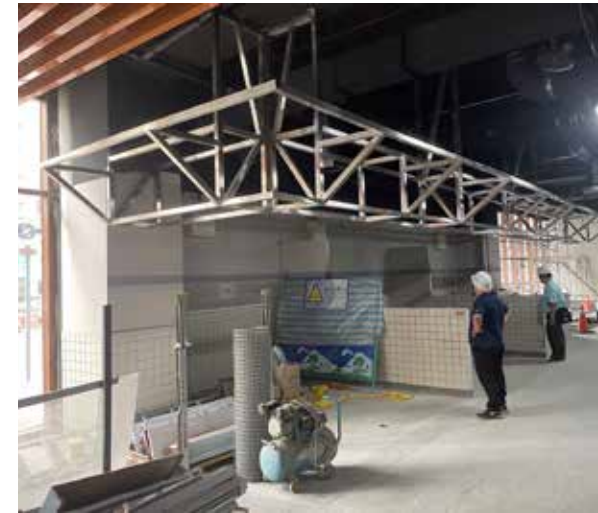
▲圖 1 攤位裝修案施工現場
