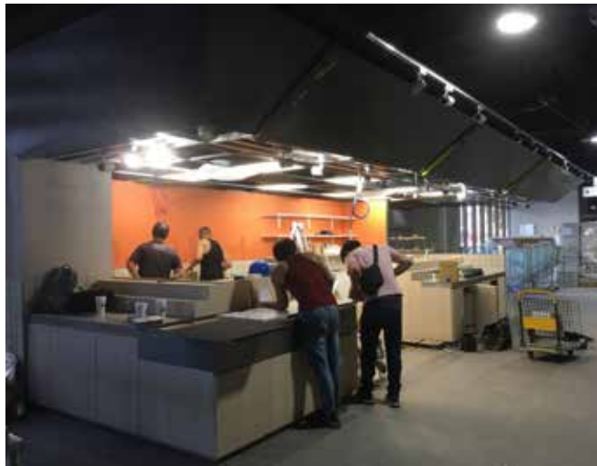
▲圖 2 攤位裝修案接近完工
