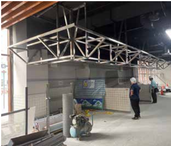
▲圖 1 攤位裝修案施工現場
