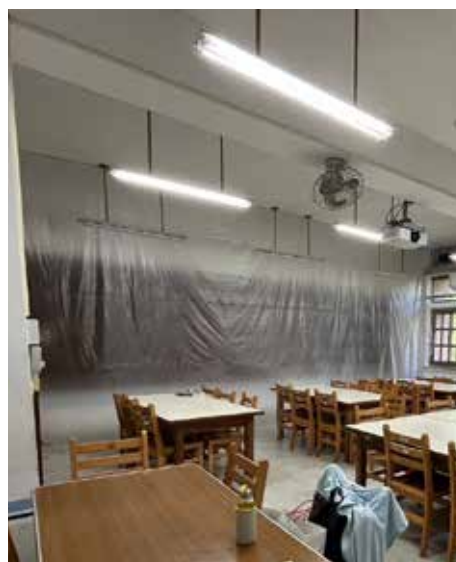
▲施工防護措施
