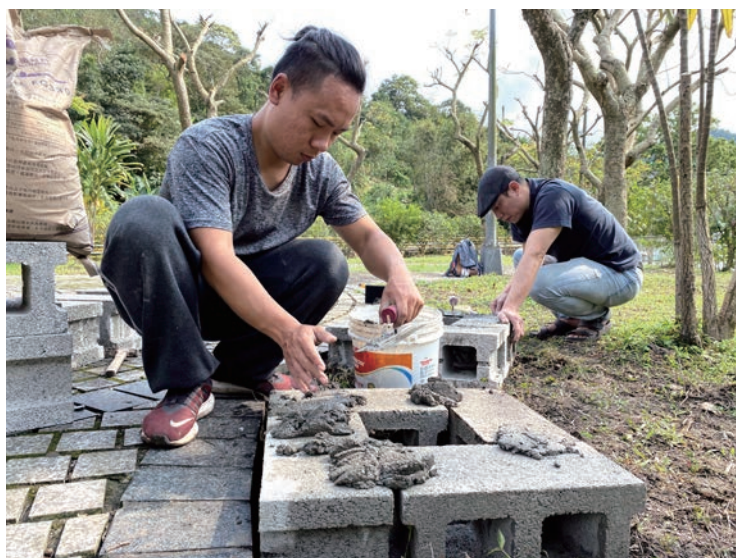
▲雨水回收桶施工中。圖源：南港茶水間。
