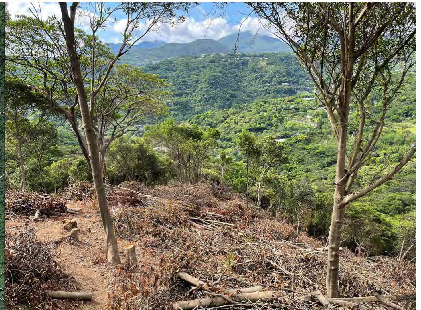
▲圖 3 大崙尾山碳中和複層林營造案伐木造林現場 圖片來源：廖鎮洲（2021）
