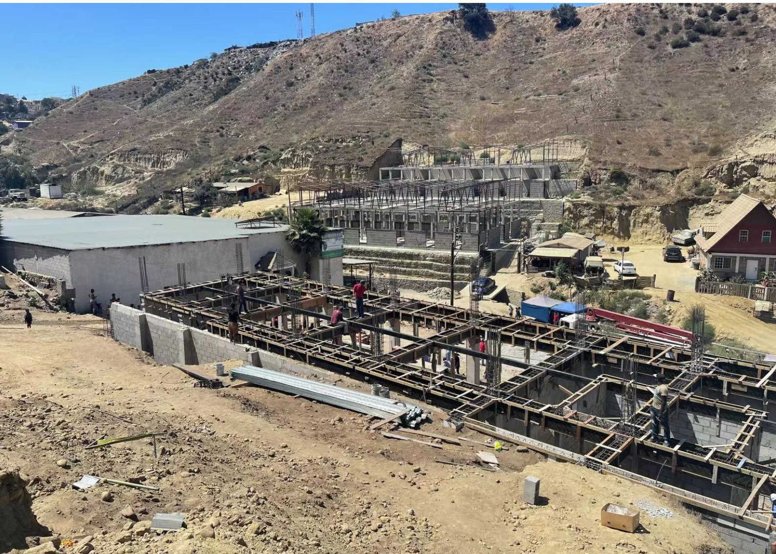
▲ 墨西哥中南美難民營兩座社區廚房施工照 供圖 | 林偉
