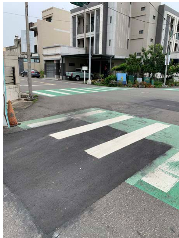
▲驗收時須確認管線單位施作的鋪面平整度及標線復舊。
