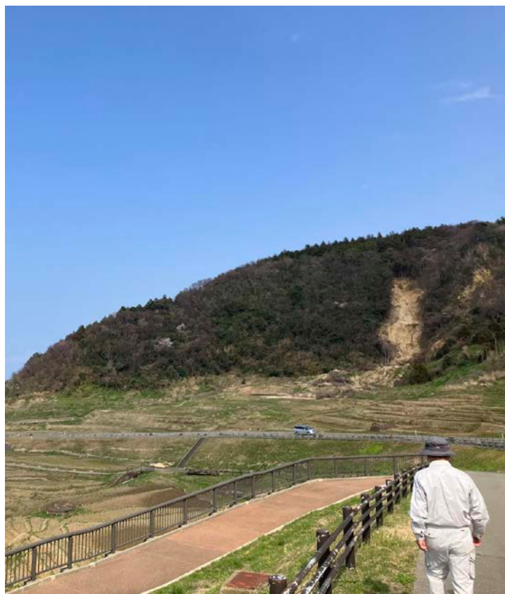
▲受右側大面積崩塌影響，灌溉設施仍在修復中的白米千枚田 | 圖片來源：作者提供
