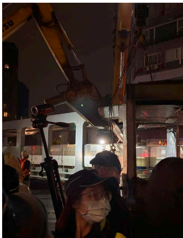
▲圖 11 拆除當日，大型機具拆解天橋 | 圖片來源：陳毓文拍攝
