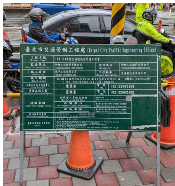
▲圖 12 天橋拆除工程施工告示牌 | 圖片來源：賴彥霖拍攝
