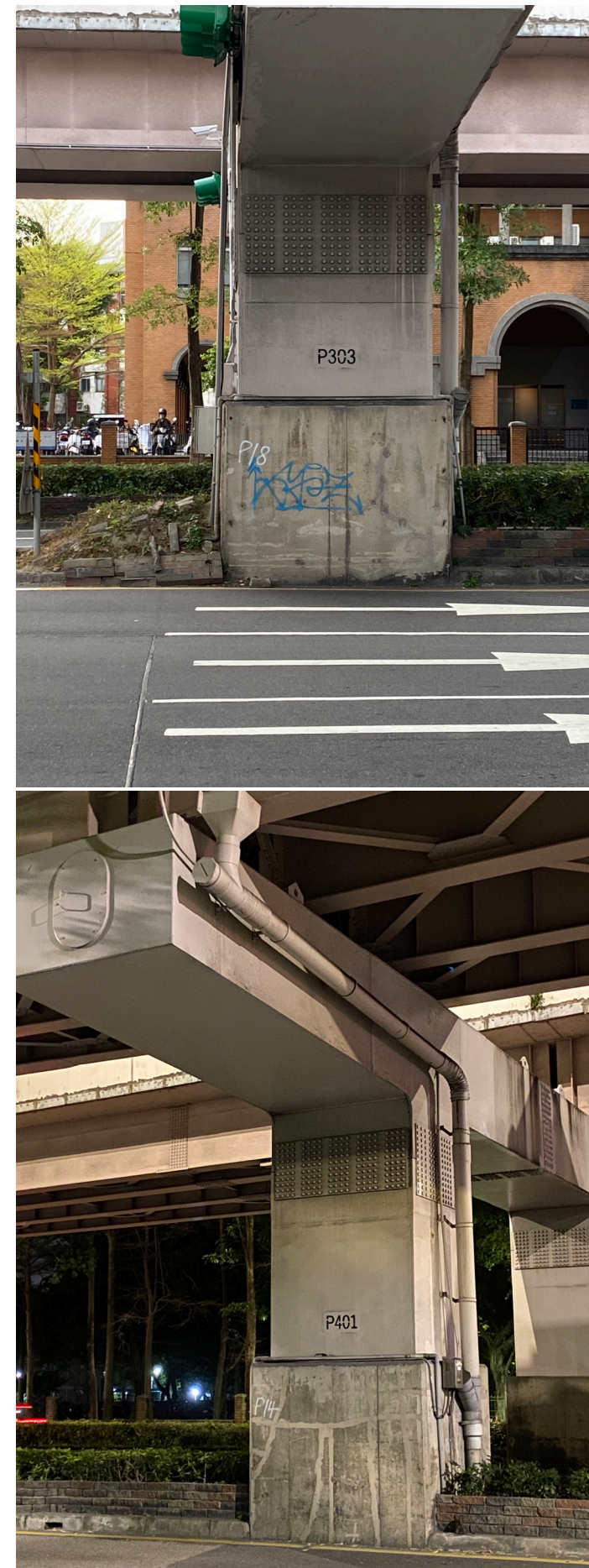
◀ 基隆路橋墩模板塗鴉 來源 | 莊千逸
