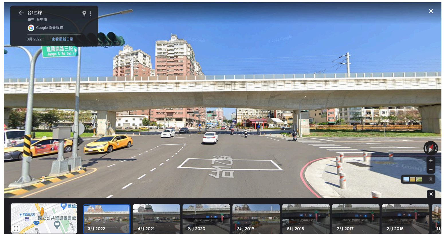
▲ 拆除後圖片：（鐵路高架化，地下道一一填平） 來源 | Google Maps
